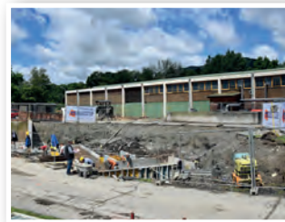
Bauarbeiten für das neue Altstoffsammelzentrum
