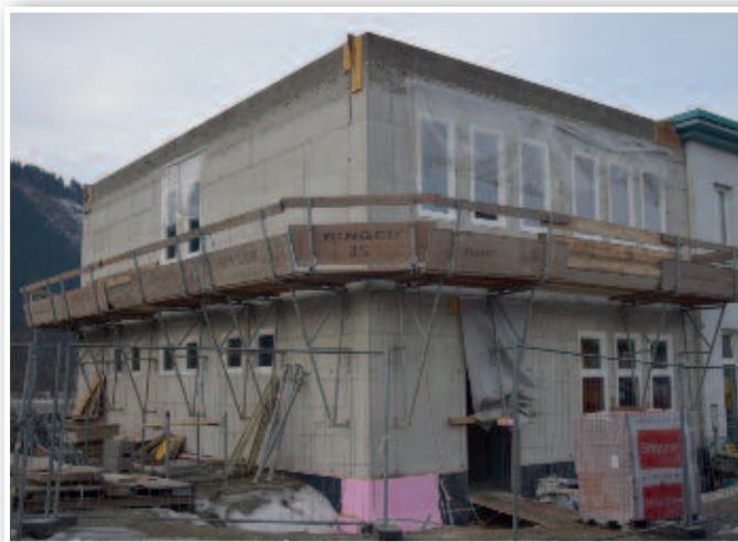
Das Verwaltungsgebäude wurde um 300 m 2 vergrößert.
