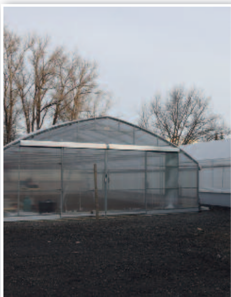
Auch zwei Folientunnel samt Arbeits- und Lagerraum für die Gärtnerei wurden am Gelände errichtet.
