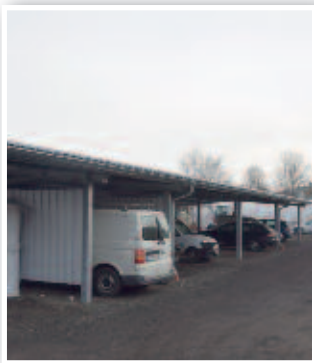
Im Außenbereich entstanden mehrere Carportflächen.
