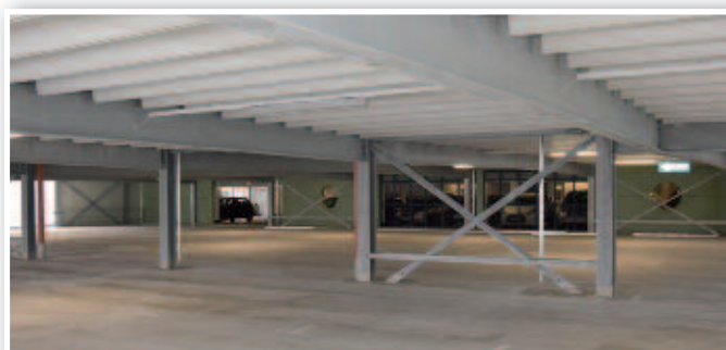
Im Frühjahr 2019 sind noch letzte Belagsarbeiten geplant.
